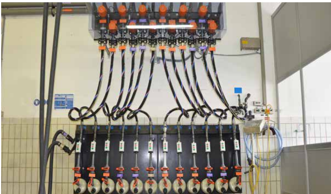
Abfüllanlagen für Säuren und Laugen
