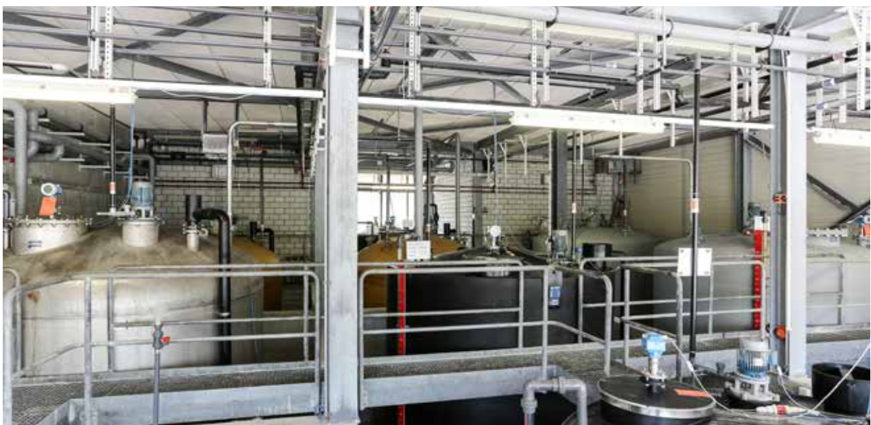
SÄUREN- UND LAUGENTANKS FLAWIL - 11 Tanks mit Gesamtfassungsvermögen von 325.000 l
