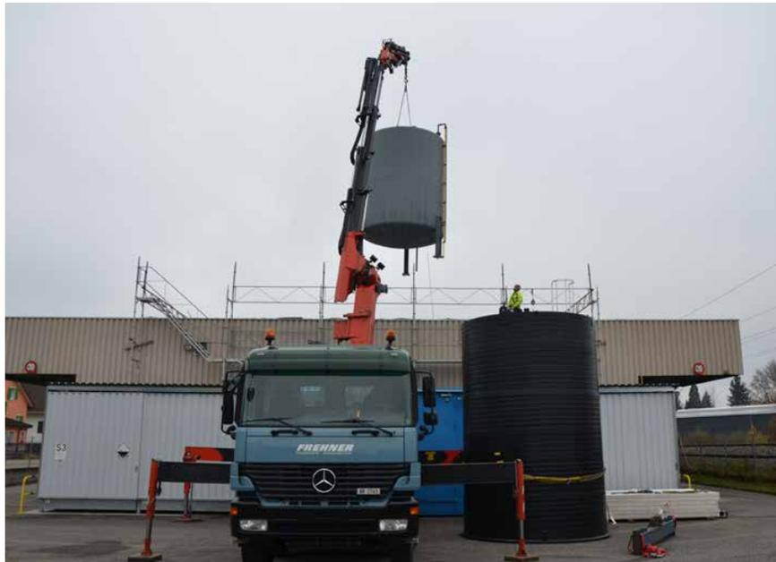
Nell'ottica di un aggiornamento continuo alle normative di sicurezza e per fornire sempre il miglior servizio al cliente, ECSA Chemicals ha sostituito nel deposito chimico di Flawil due vecchi serbatoi con due nuovi in polietilene ad alta densità e acciaio inox.
