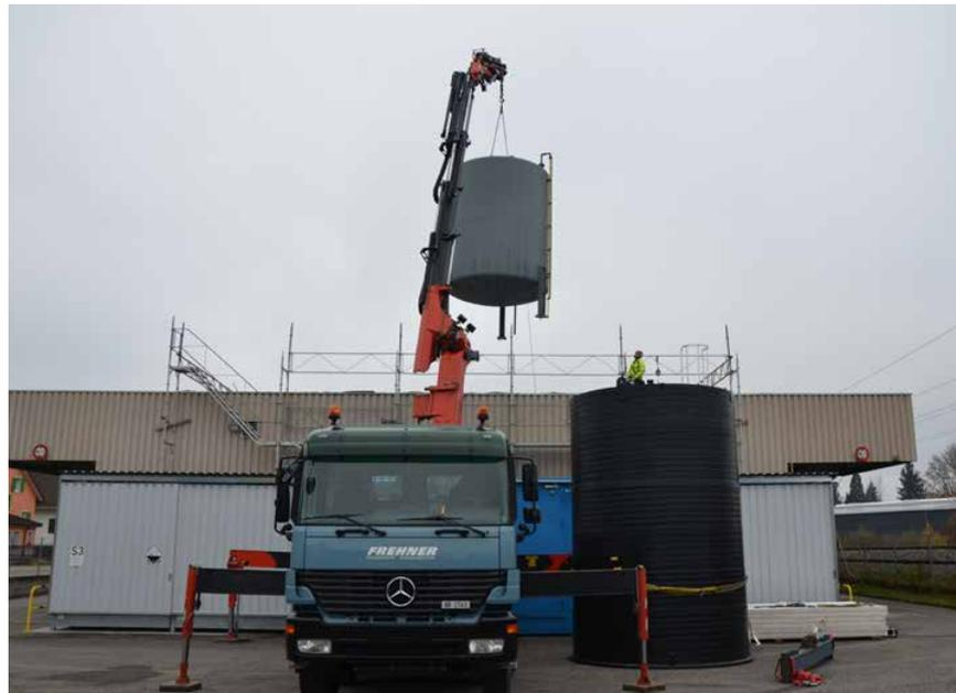
Dans l'optique d'une mise à jour continue des normes de sécurité et pour fournir toujours le meilleur service au client, la société ECSA Chemicals a remplacé, dans son dépôt chimique de Flawil, deux anciens réservoirs par des réservoirs neufs en polyéthylène haute densité et acier inox.
