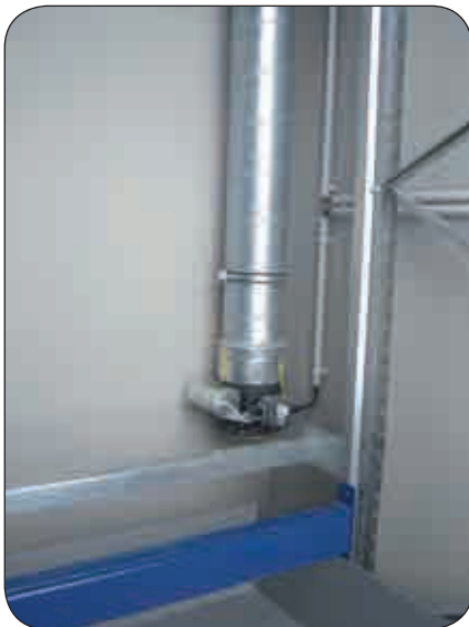
Ex-Abluftanlage inkl. brandgeschützter Lüftungselemente
