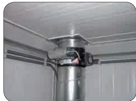
Abluftkanal mit K-90 Absperrvorrichtung
