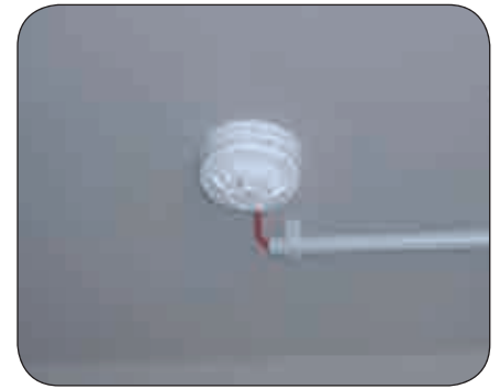
Wärmemelder zur Ansteuerung der Türfeststellanlage
