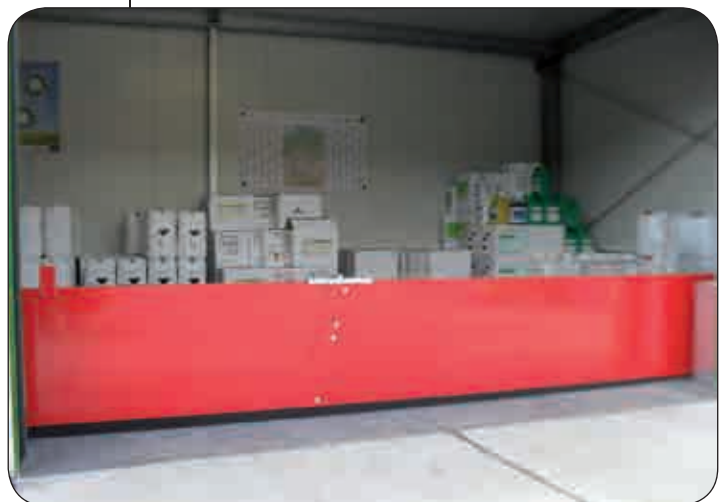
Löschwasserrückhaltung mit dreh-klappbarer Barriere
