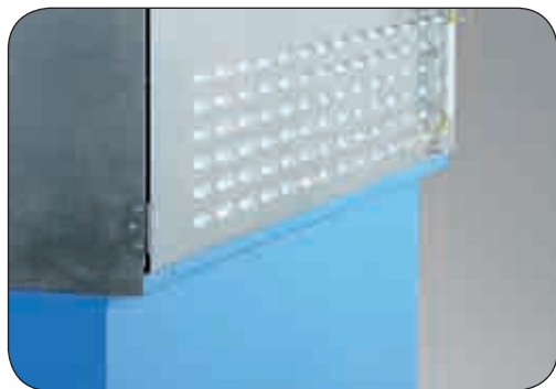
Lüftungsöffnungen in den Seitenwänden
