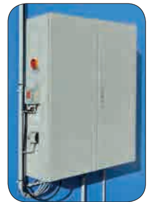
Schaltschrank mit zentraler Steuerung und Bedienelementen
