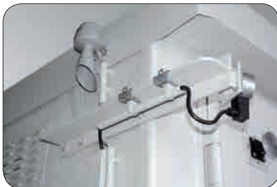
- Ex-geschützte Abluftüberwachung mit Signalhupe - Türhalteanlage
