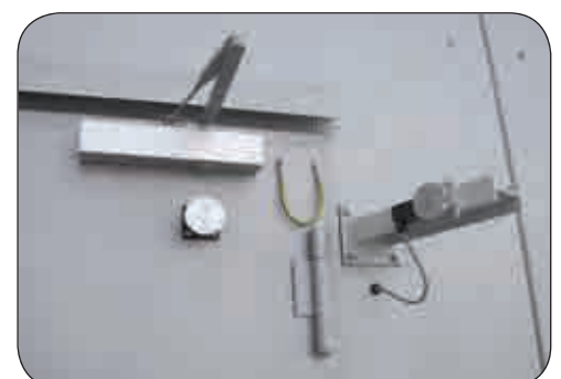
Türfeststelleinrichtung mittels Türhalte magnet
