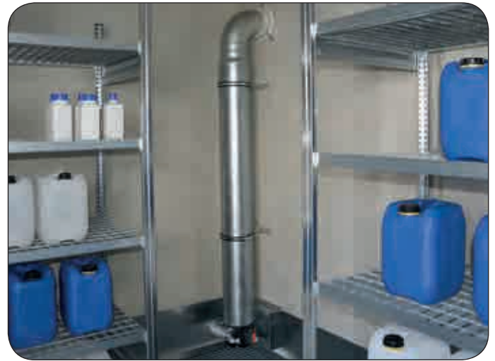
Ex-Abluftanlage inkl. Abluftkanal bis Auffangwanne
