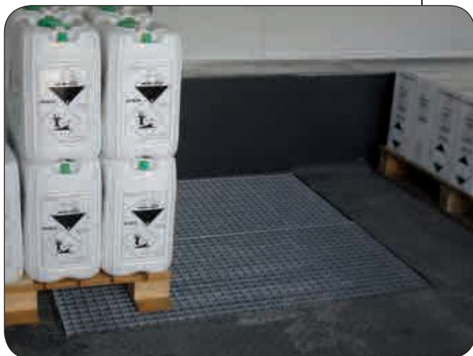
Geneigte Lagerfläche mit Pumpensumpf
