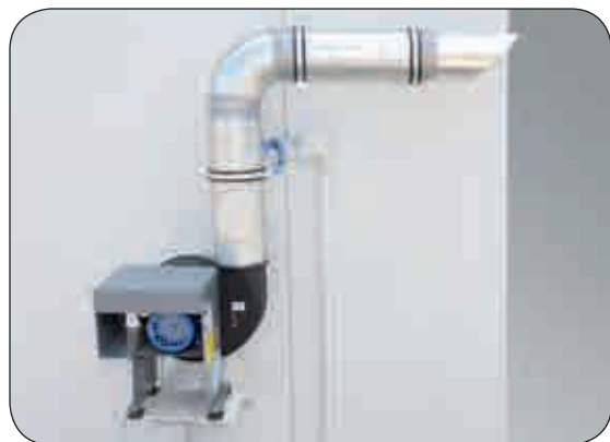
Ex-geschützter Abluftventilator inkl. Abluftüberwachung
