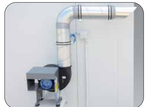
Ex-geschützter Abluftventilator inkl. Abluftüberwachung
