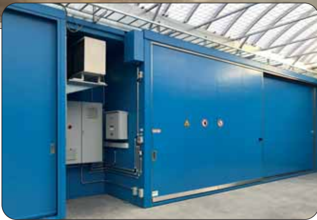
◆ Separater Brandabschnitt mit integriertem Brandschutzcontainer
