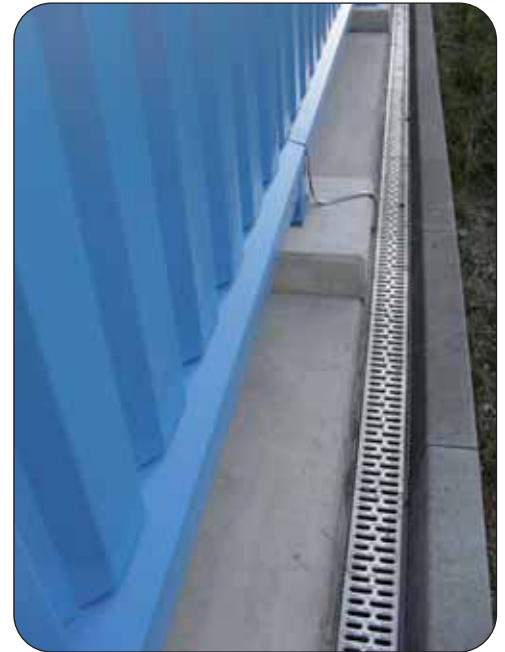
Löschwasserrückhaltung
