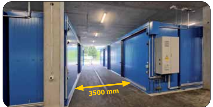
◆ Geringe Gangbreite durch den Einsatz von Schiebetoren
