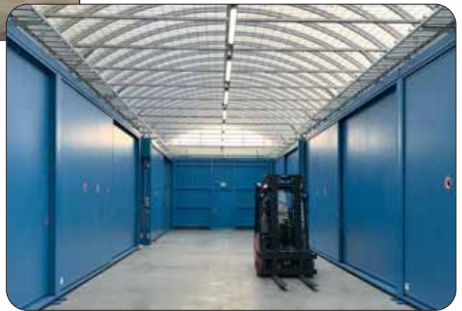
◆ Gangüberdachung mit Dachlichtband ◆ Gangbeleuchtung
